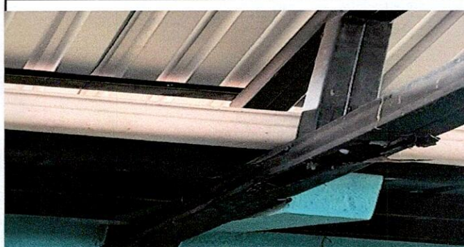
Foto 4:Mejoramiento de estructura metálica y cubierta de lamina del techo del patio
