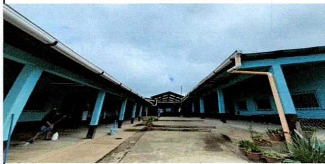
Foto 6: Pintura de lamina de tres salones de clase
