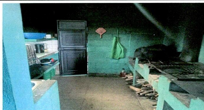
Foto 3: Reparación y sustitución de gabinete y su área
